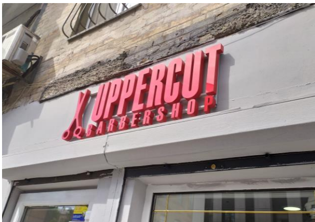
[ Вивіска в м.Дніпро. Матеріали: об'ємні букви з кольорового акрилу, металевий каркас, внутрішня підсвітка світлодіодною лентою. ]
