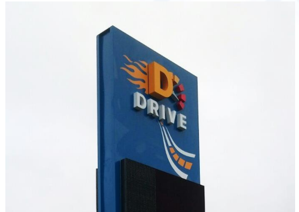
[ Стела АЗС в м.Синельніково. Матеріали: металев.каркас, композ.лист, об'ємні елементи з акрилу та ПВХ, внутрішня підсвітка світлод.кластерами. ]
