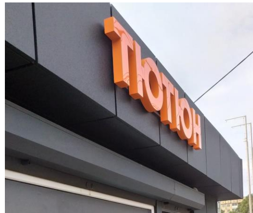
[ Вивіска в м.Дніпро. Матеріали: об'ємні букви з кольорового акрилу, металевий каркас, внутрішня підсвітка світлодіодними кластерами. ]
