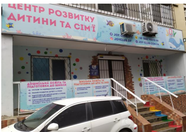
[ Вивіска в м.Дніпро. Матеріали: натяжка банера з друком на металевий каркас, зовнішня підсвітка прожекторами на кронштейнах. ]
