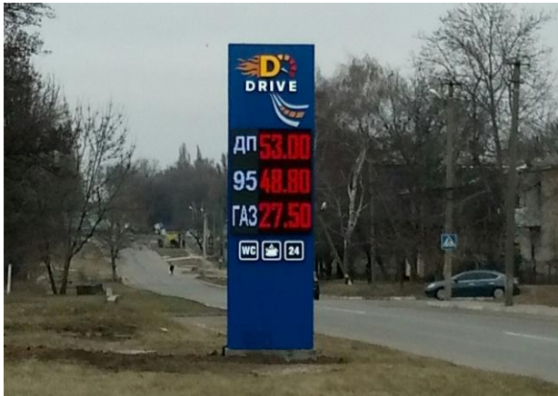
[ Стела АЗС в м.Синельніково. Матеріали: металев.каркас, композ.лист, об'ємні елементи з акрилу та ПВХ, внутрішня підсвітка світлод.кластерами. ]
